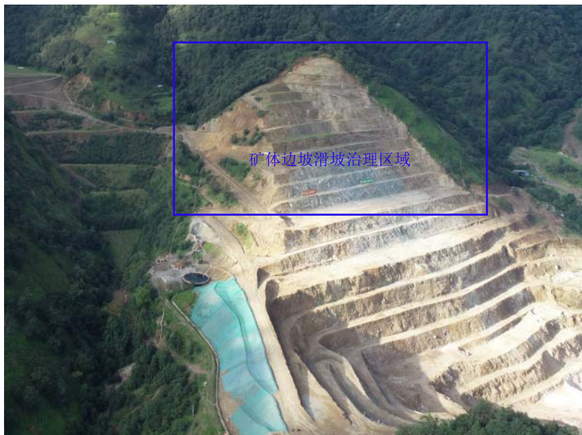
图 5-3 矿区与矿体边坡滑坡治理区域现场照片
