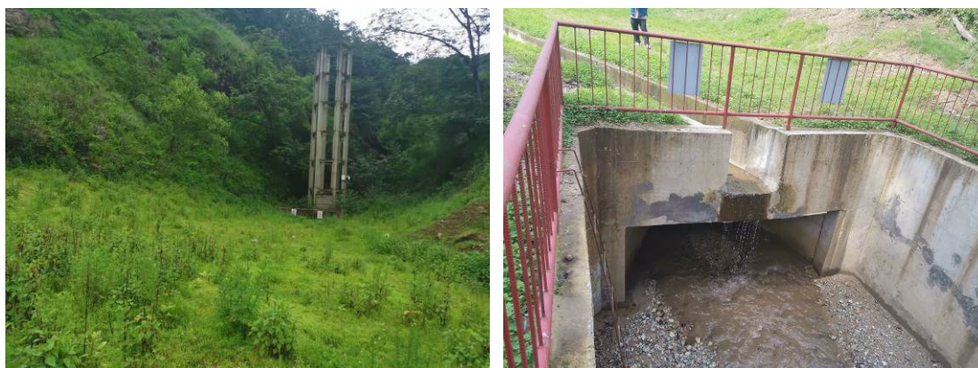
尾矿库上游拦洪坝、排洪竖井
