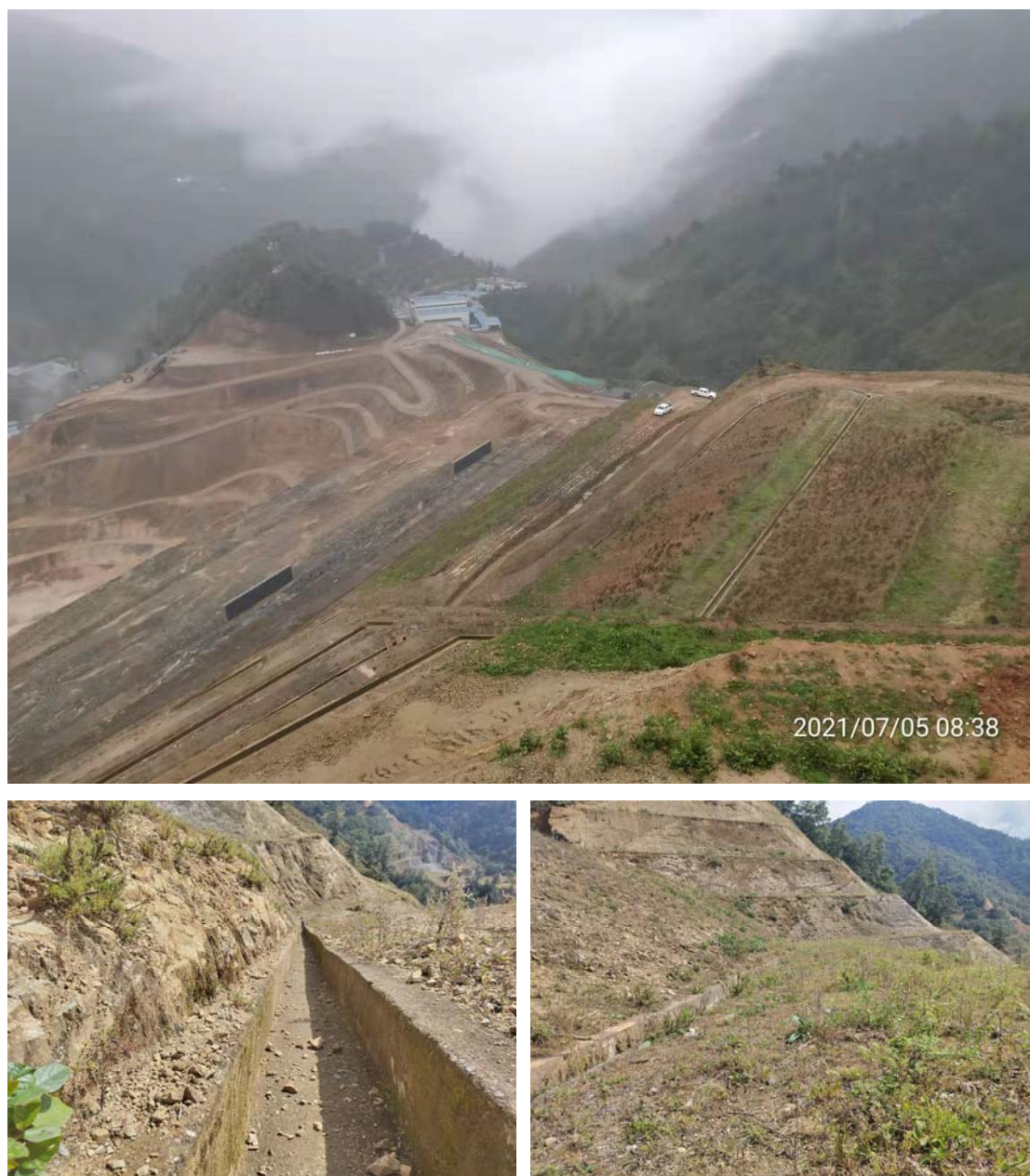
图 5-4 矿区顶部滑坡治理区域截排水沟、植被恢复现场照片
