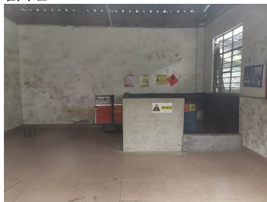
危废暂存间地面硬化
