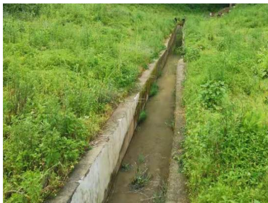
尾矿库库区截排水沟
