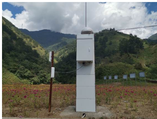
尾矿库在线监测系统
