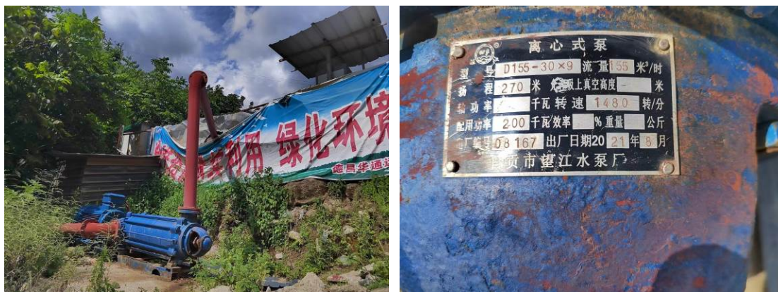
回水泵建设情况
