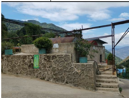
柴油储罐围堰
