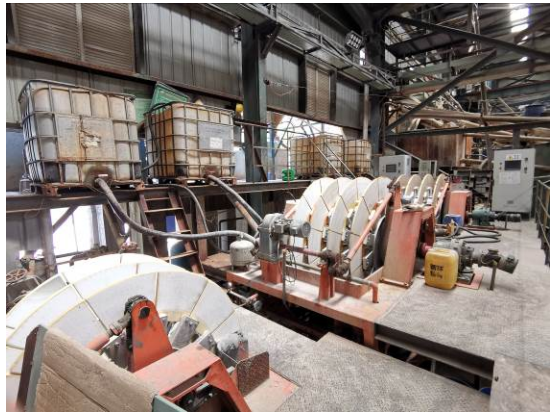
精矿脱水设备
