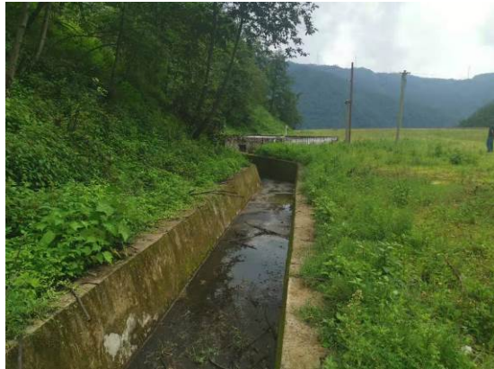
排土场外围截排水沟
