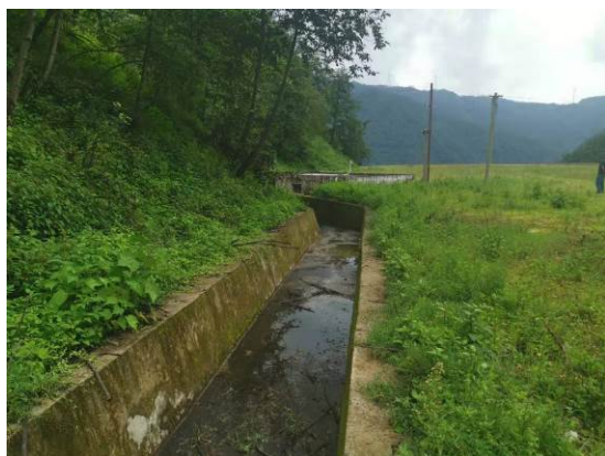
排土场东侧截排水沟
