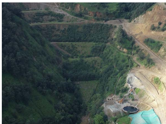
排土场底部拦渣坝及坡面植被恢复情况
