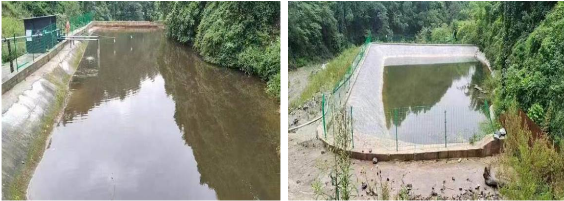
华通运尾矿库下游渗滤水收集及回用设施
