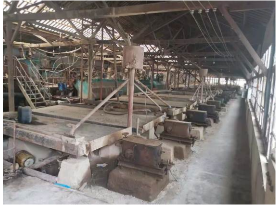
废弃的二选厂车间内部
