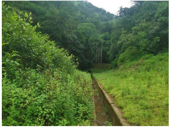
库区排水设施
