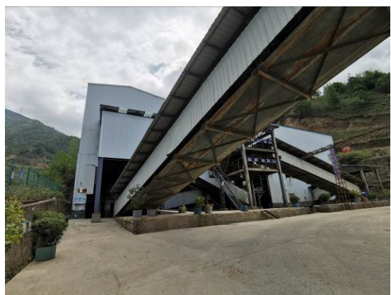
破碎、筛分车间及密闭皮带走廊
