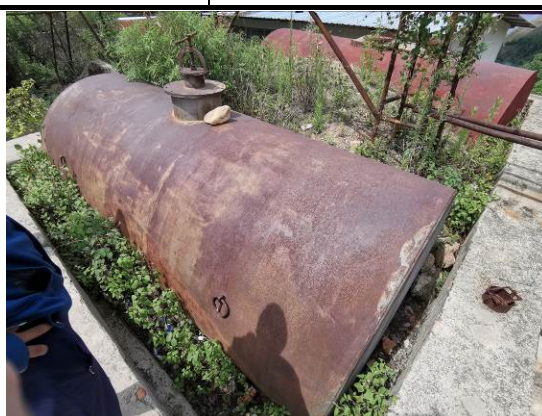
柴油储罐围堰
