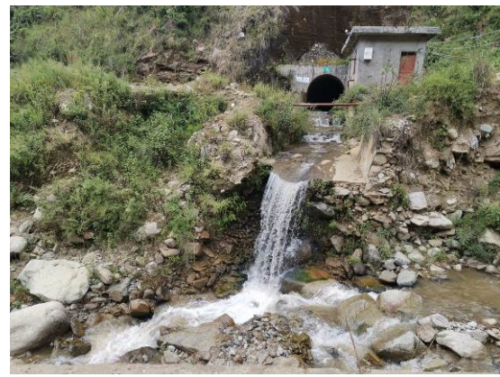
排水隧洞出口
