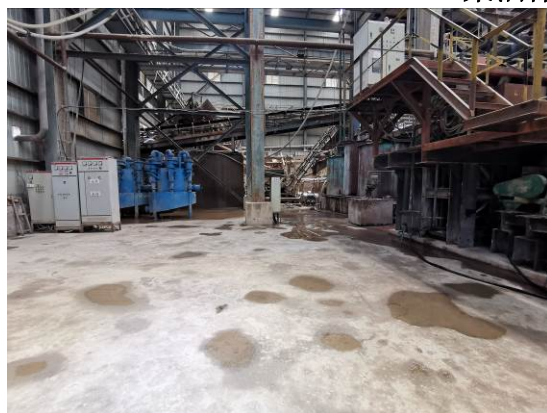
生产车间地面混凝土硬化
