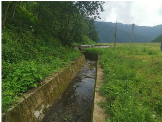
排土场东侧截排水沟
