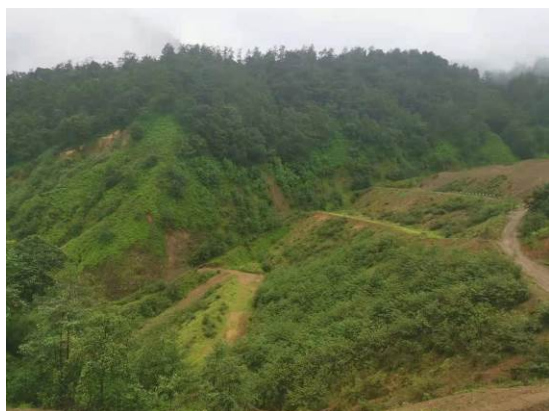
排土场坝坡植被恢复情况
