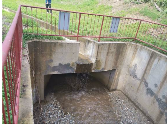
排水斜槽+排水隧洞
