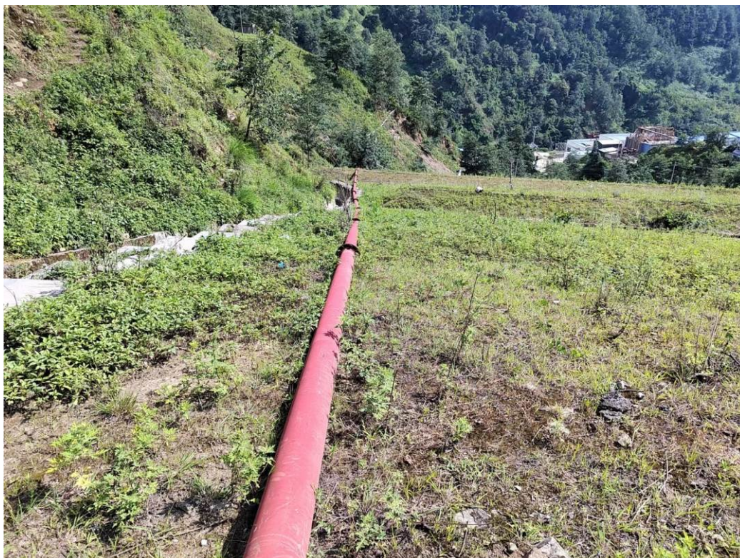
回水管道建设情况
