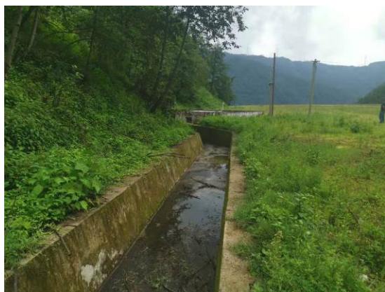
排土场东侧截排洪沟
