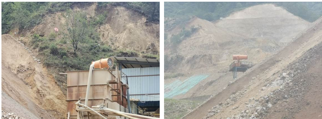
原矿堆场 2 台除尘雾炮机
