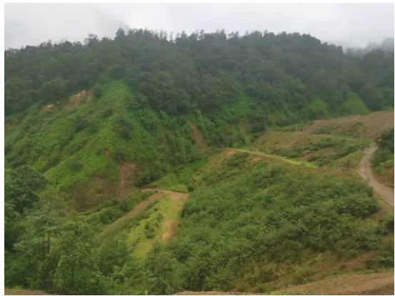
排土场边坡植被恢复现状
