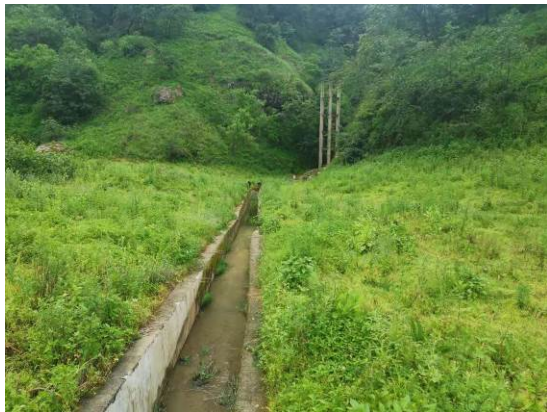
库区排水设施
