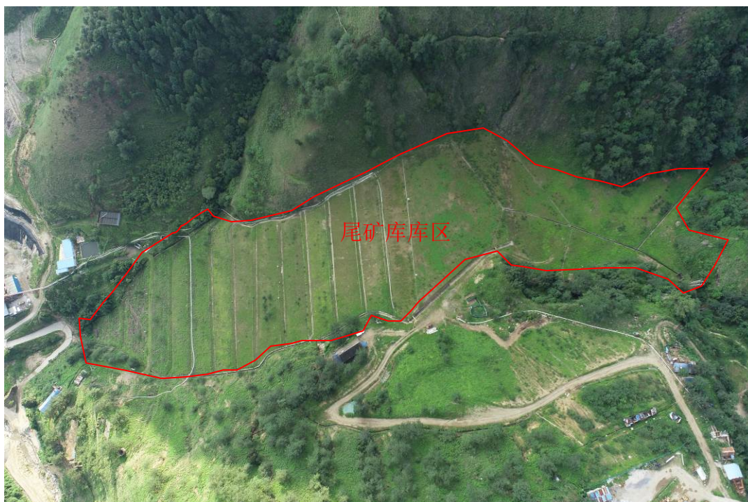
刘家沟尾矿库库区植被恢复情况全貌
